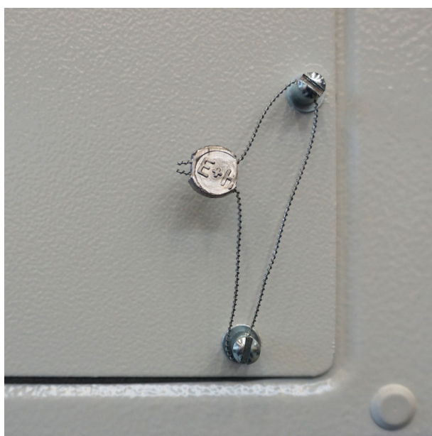
图 27 使用封锁线锁死螺丝
